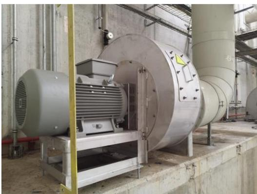
Imagem: Detalhe do ventilador de um dos tuneis de compostagem
