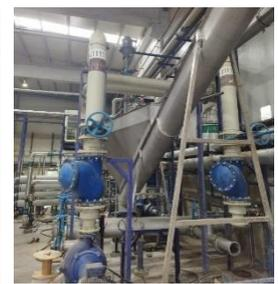
Imagens: Hidrociclone | Ilustra os equipamentos que permitem o aumento da capacidade do digestor da linha 401.
